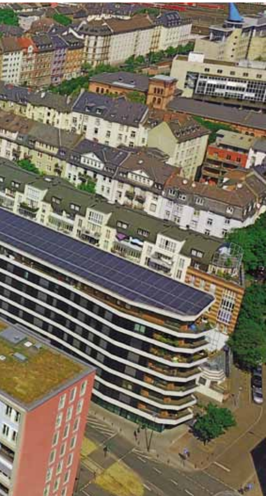
Bild Aktiv-Stadthaus in der Speicherstraße, Frankfurter Westhafen
