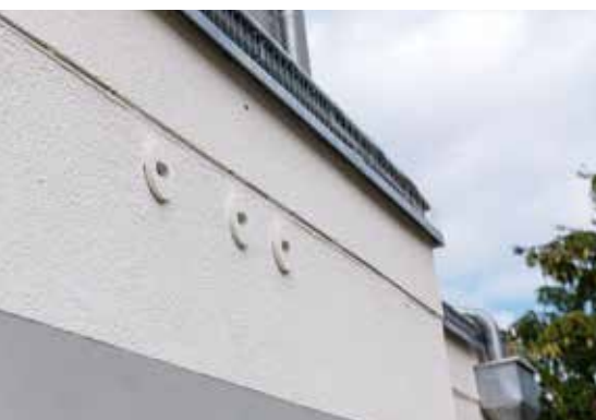
Die Häuser Im Földchen haben spezielle Brutkästen für Mauersegler, die von den Vögeln sofort angenommen wurden.
